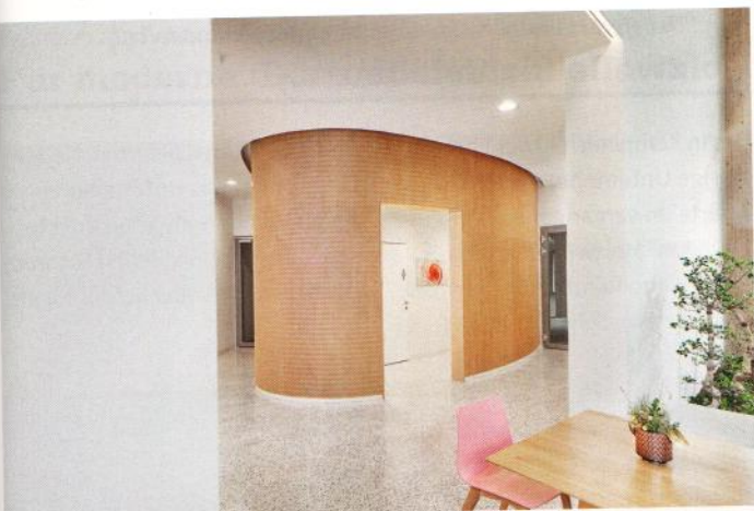
Die Verkleidung der gebogenen Flächen der im Gebäudeinneren liegenden Server- und Funktionsräume erfolgte mit der Design- und Akustikplatte Dukta Linar.
