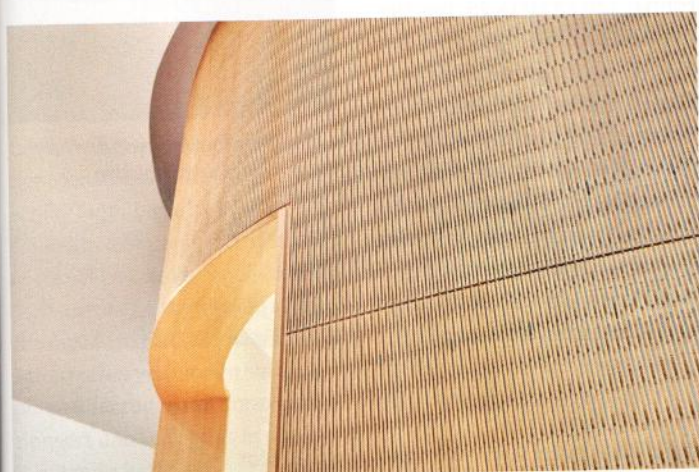
Sauber detailliert: Die Befestigung der Dukta-Platten erfolgte, wie hier an der Verkleidung der Zugänge zu den Sanitärräumen, auf biegbaren Metall-Montageleisten.
