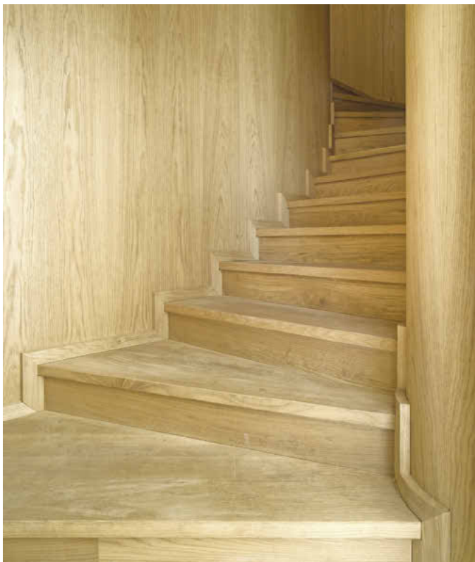
Treppenantritt und Wandverkleidung in Eiche
