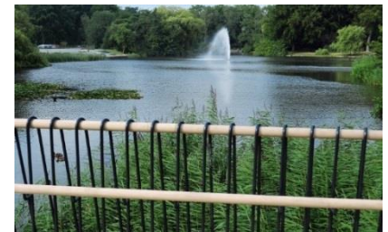
Handlauf für Brückengeländer
