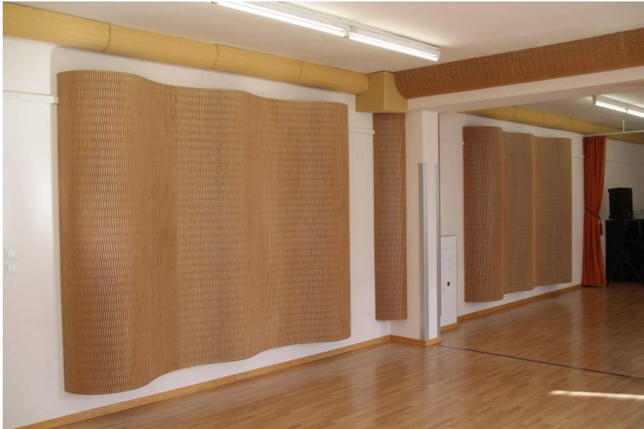
Insgesamt waren 6,6 m<sup>2</sup> Eckabsorber und 16,9 m<sup>2</sup> Wandabsorber installiert.
